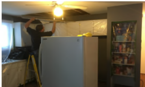
Restriction de zone et protection de contenu avant travaux ouvertures
