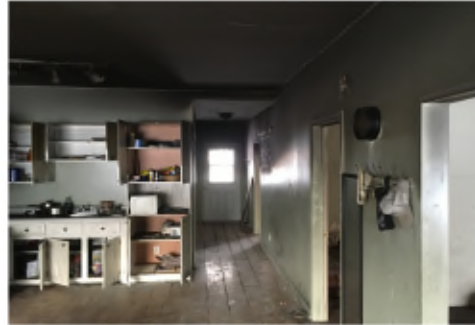
Intervention en urgence après incendie Nettoyage après sinistre
