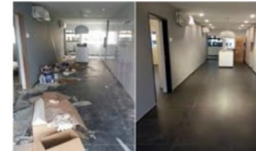
Ménage après travaux de construction
